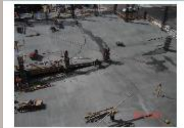
Parking garage concrete pour
